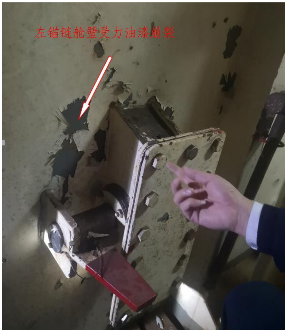
图 6：左锚链舱壁受力油漆崩裂
