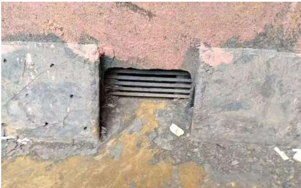
图 6：货舱和污水收集舱之间舱壁上的格栅（从货舱摄）
