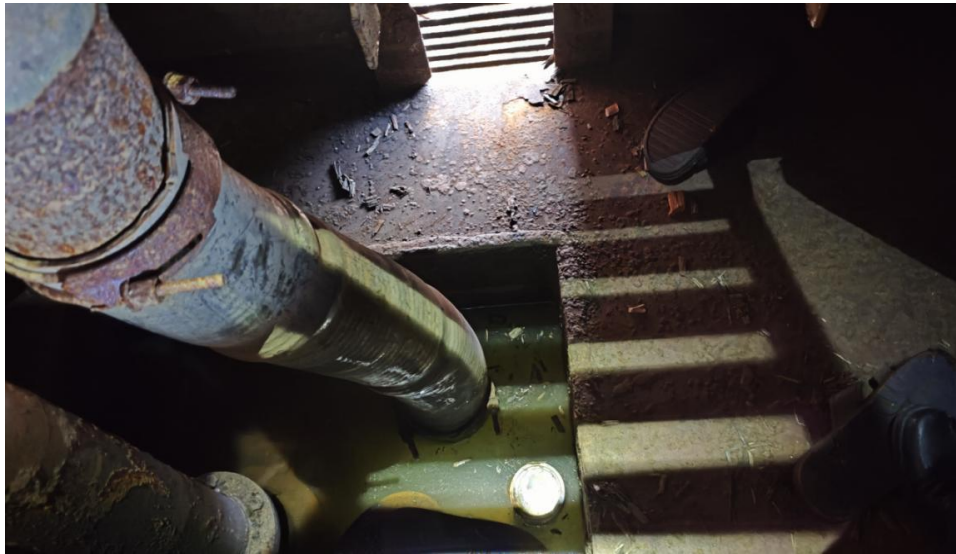
图 5：货舱和污水收集舱之间舱壁上的格栅（从污水舱摄）
