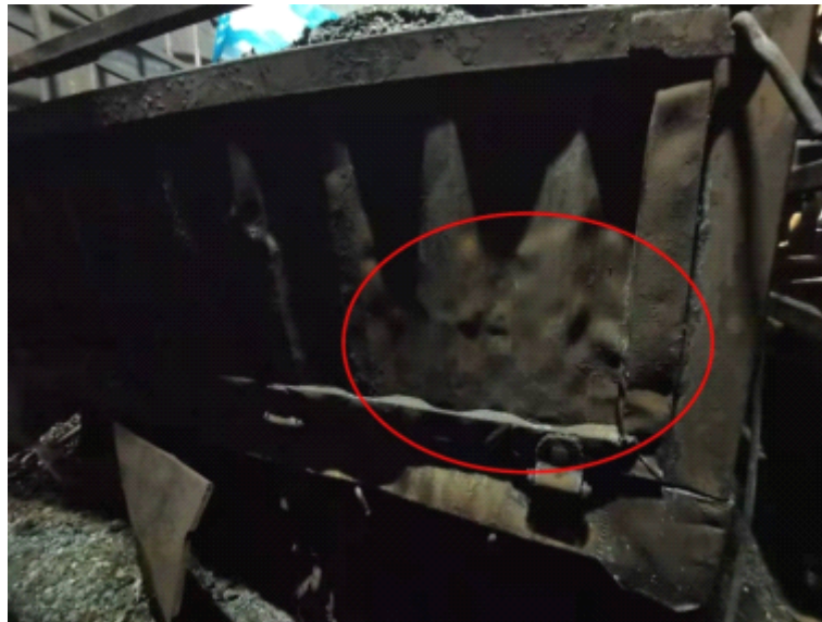
图15.“辽 F6707挂”车厢后挡板受热变形痕迹
