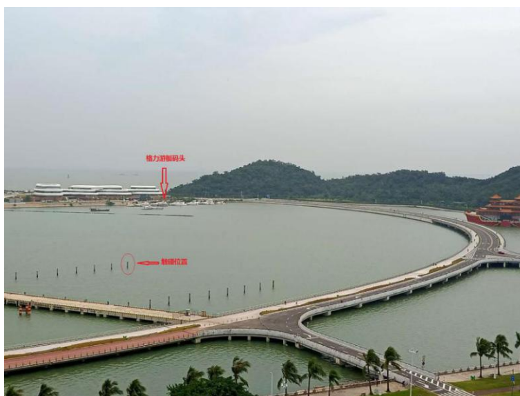
图 5：新月桥旁码头灌注桩俯视图（非事发时段拍摄）
