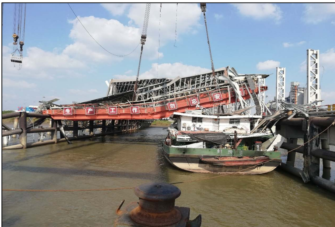
图 14：B 码头损失情况
