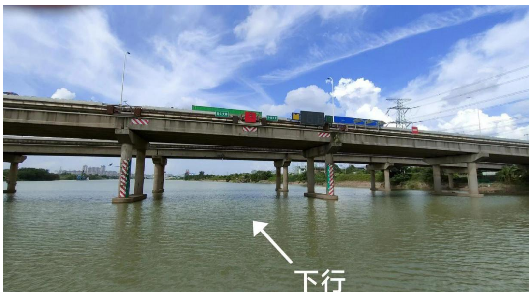
图 2：南头大桥外观
