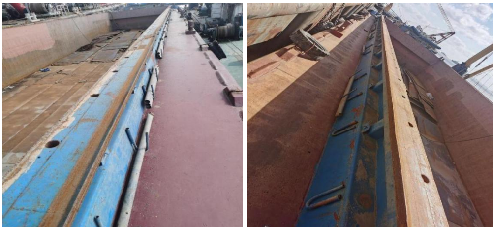
图22: “海之运918”轮舷墙、主甲板照片
