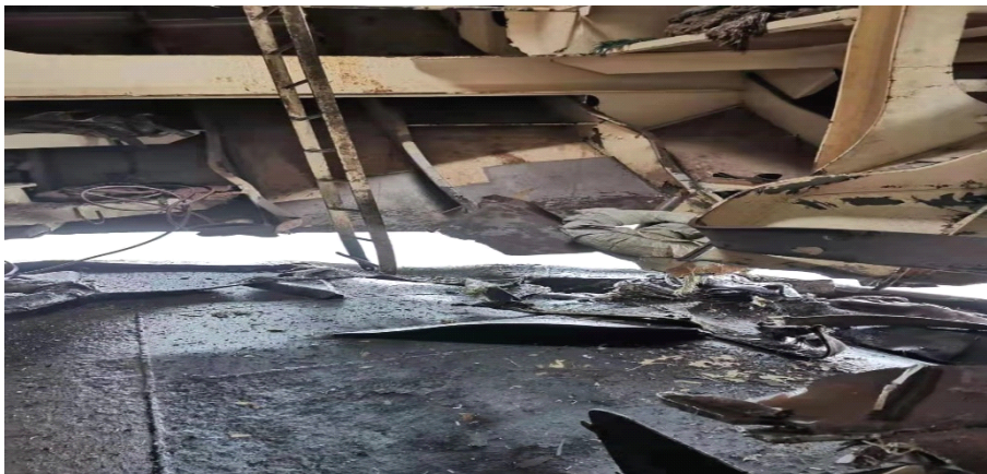
图 14 碰撞发生后“义海”轮船艏舱破损情况
