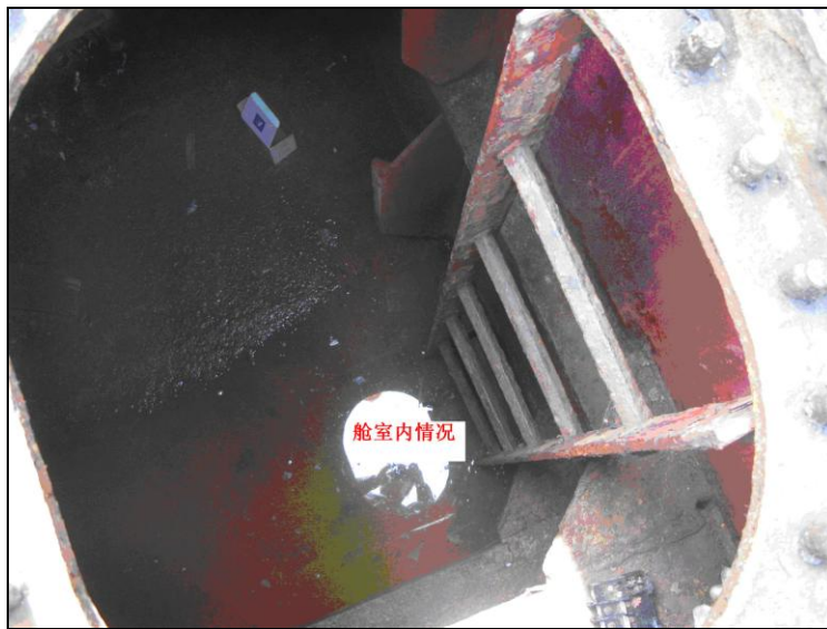
图4：道门打开后舱室内情况
